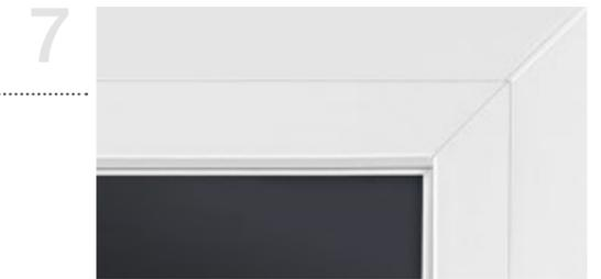
**Штапик Интернорма** идеально соответствует дизайну окна и создает гармоничную наружную поверхность
