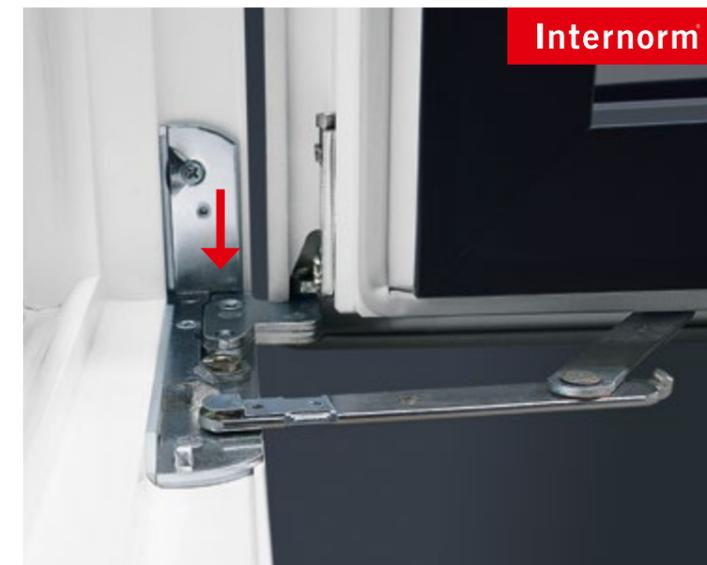
Фиксированный угол поворота и опора фурнитуры по всей поверхности
